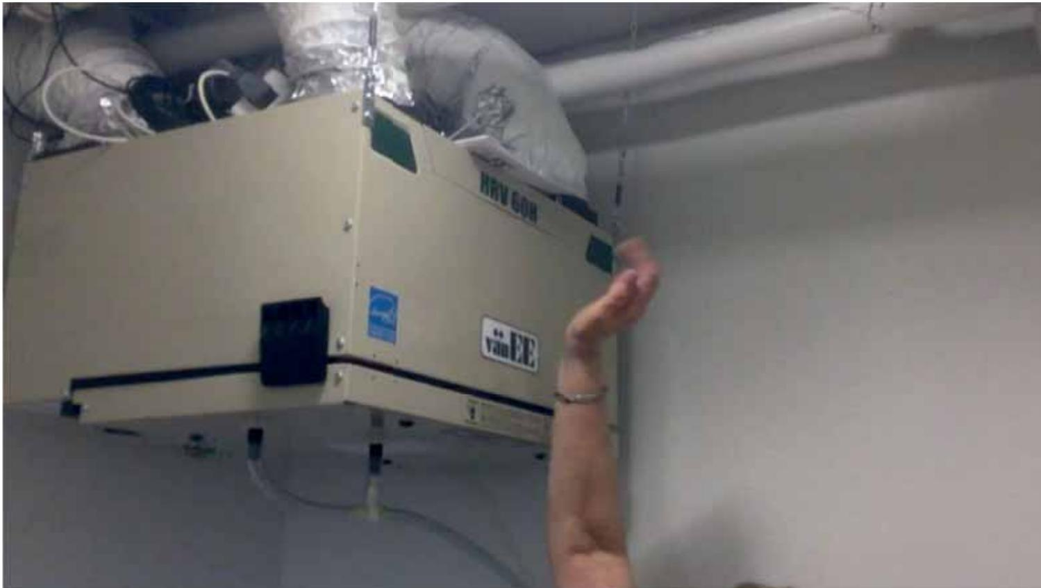
Étape 4: Retirer les deux filtres noirs en retirant l'attache de métal et en les faisant glisser
